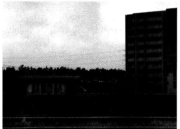
仙台市若林区に建設中の震災復興公営住宅
